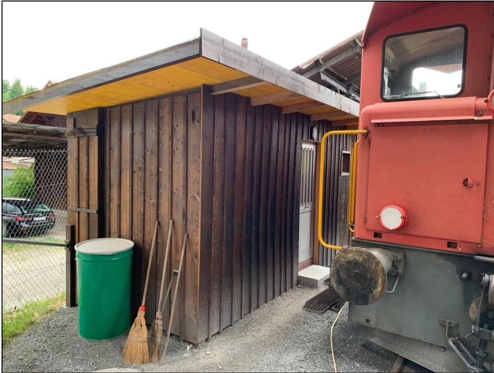
Das fertige WC Haus...
