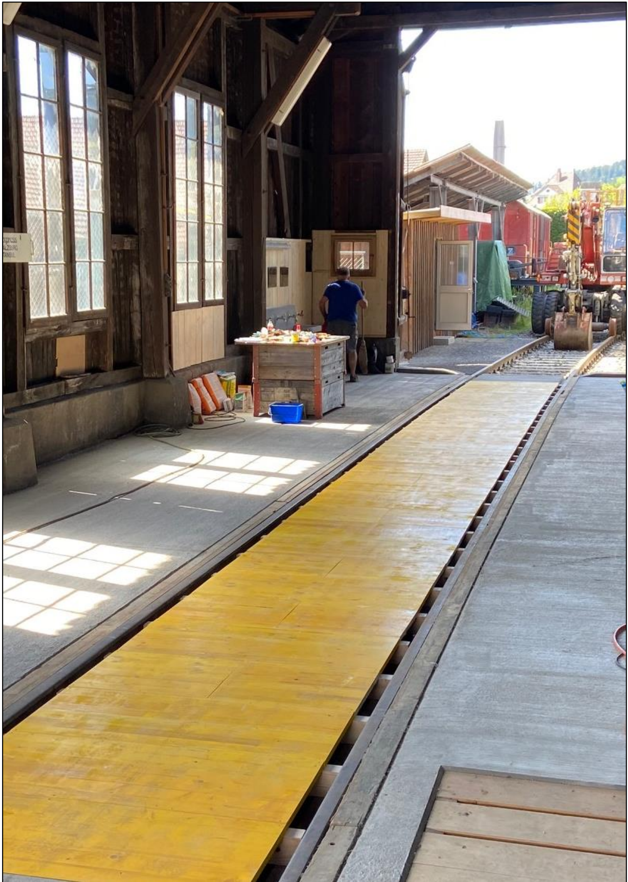
Im Depot haben wir die Grube für einen Grossanlass Ende August abgedeckt, damit eine grosse Festfläche entstehen konnte.
